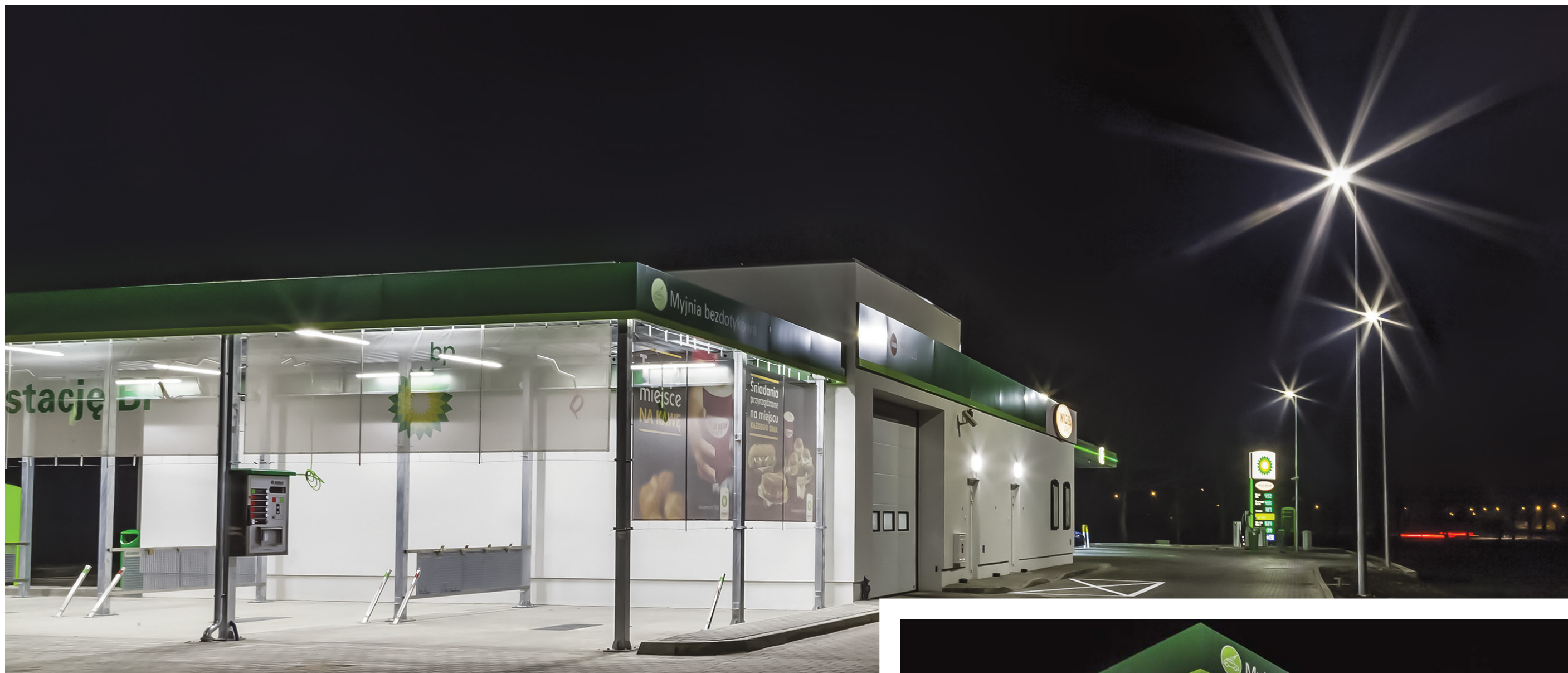
Oświetlenie Stacji paliw w Bochni.
